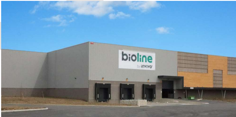
Nouvelle usine (LS Production) à la Chapelle d'Armentières (59)
